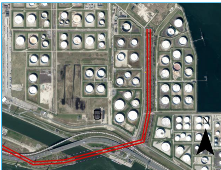
Figuur 367. Team Terminal B.V. Een hoogspanningslijn tussen de opslagtanks in.
