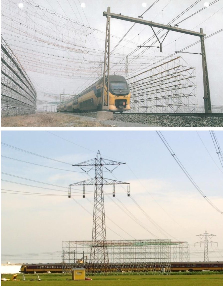
Figuur 1. Jukken over het spoor bij werkzaamheden aan geleiders bij spoorkruisingen.
