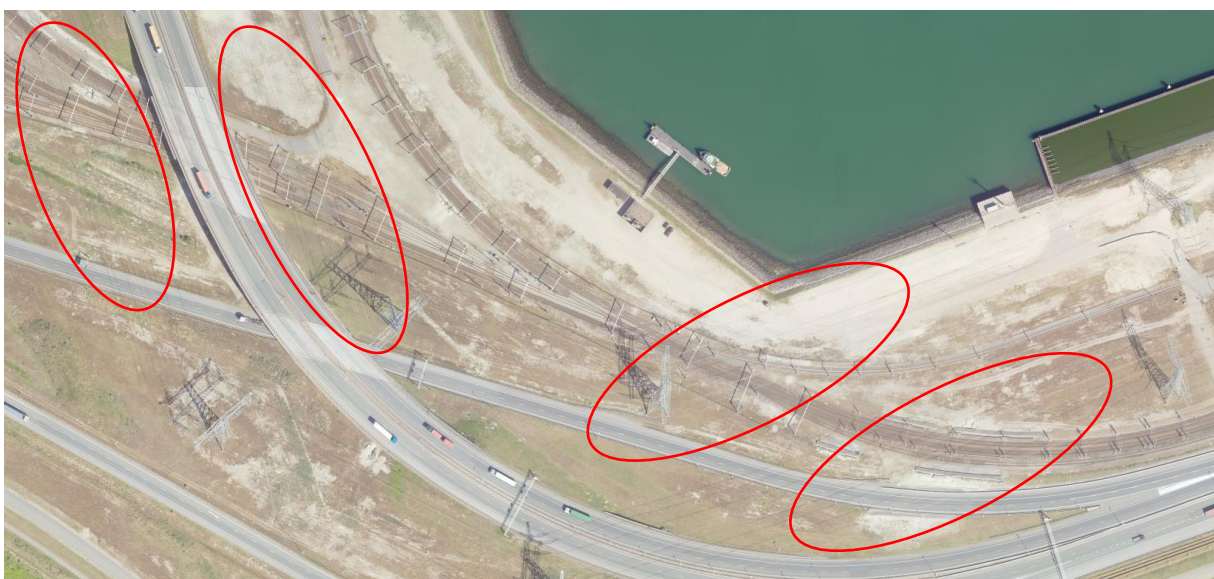
Figuur 19. Kruisingen hoogspanningslijnen met emplacementen in C2-bocht van de Maasvlakte, bron: Cyclomedia.
