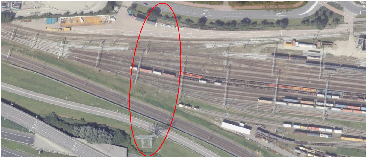
Figuur 18. Luchtfoto van de locatie Waalhaven Zuid waar hoogspanningslijnen het emplacement kruisen, bron: Cyclomedia. Onderste foto is situatie voor vernieuwing, bovenste foto's na vernieuwing eind 2020/begin 2021.
