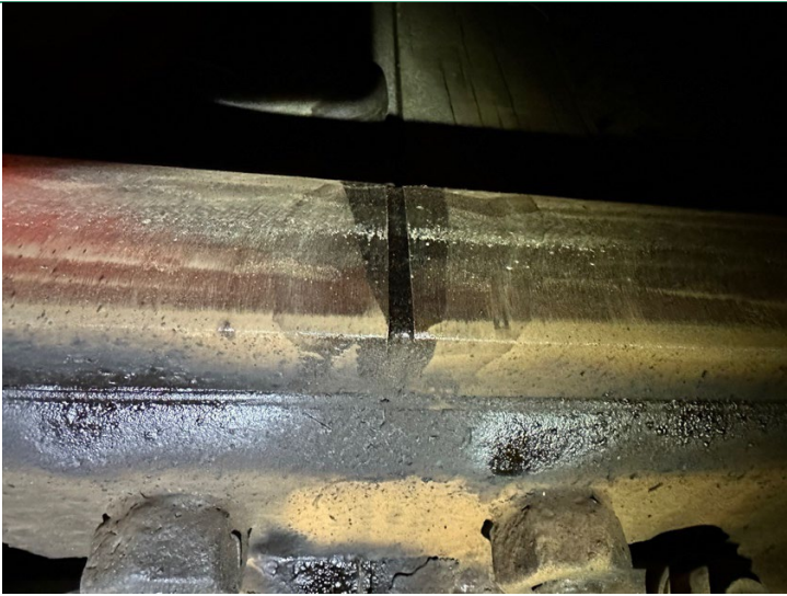
Kopvulling aangebracht, niet gehele las zwart gemaakt
