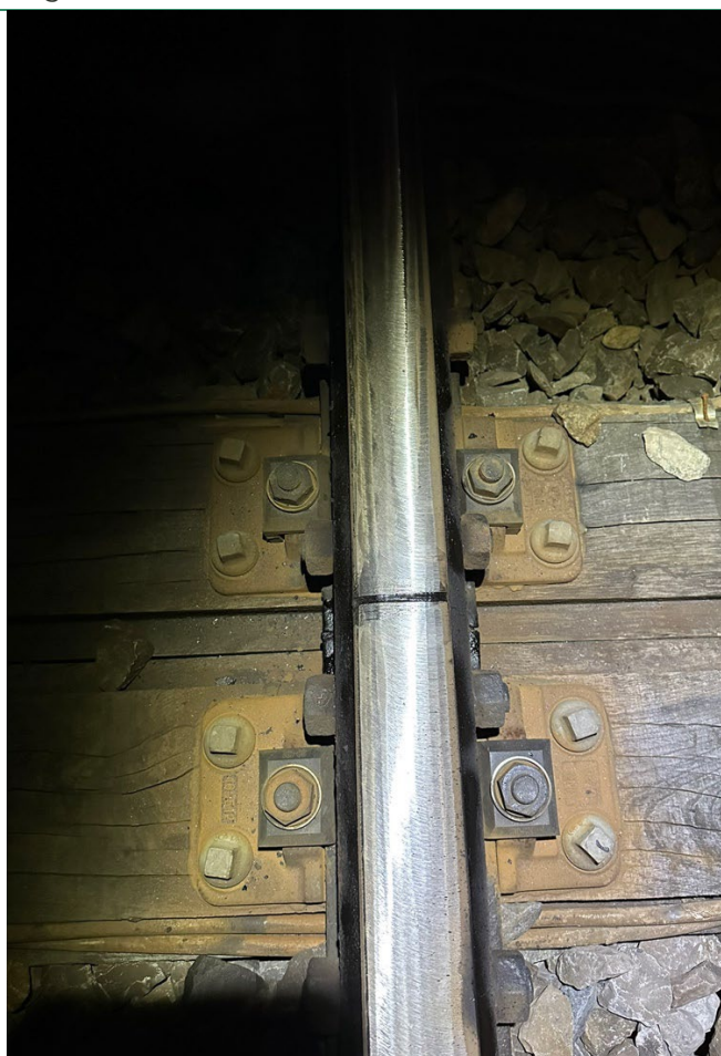
Las geslepen en kopvulling aangebracht
