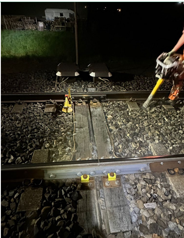
Wackeren nadat las op hoogte is gebracht
