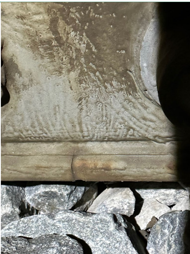
Kleine opening onder bij de las linker zijde
