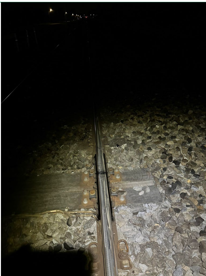
Ballast niet netjes afgewerkt, maar voldoet wel
