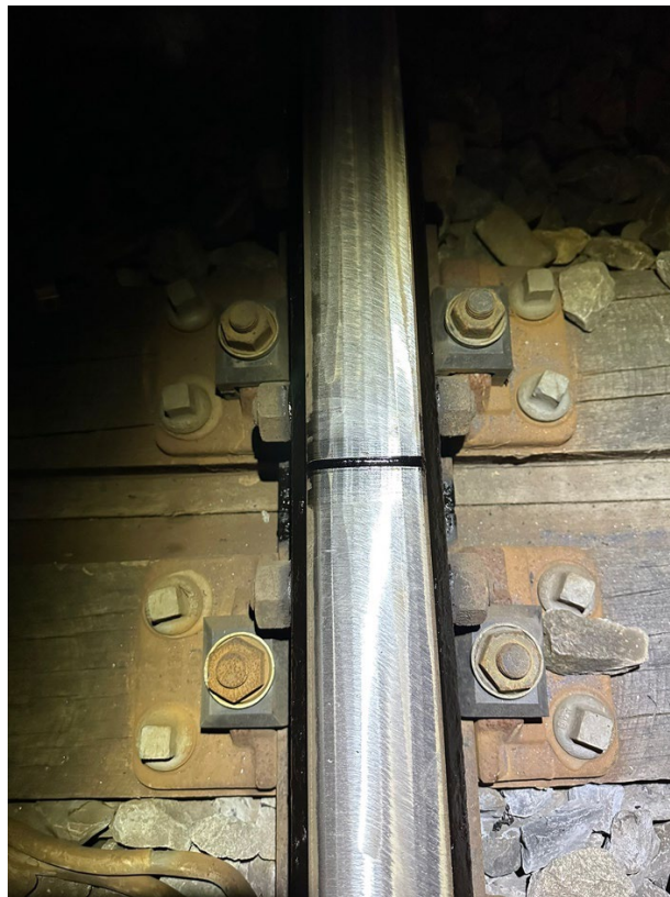
de kopvulling aangebracht na het slijpen
