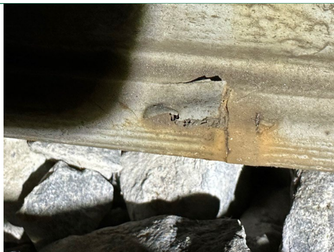
Kleine opening onder bij de las rechter zijde
