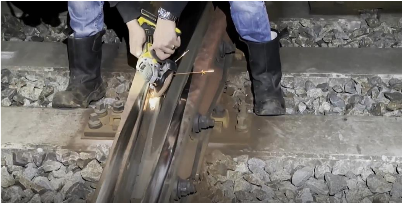
Figuur 3 Handmatig slijpen van puntstuk
