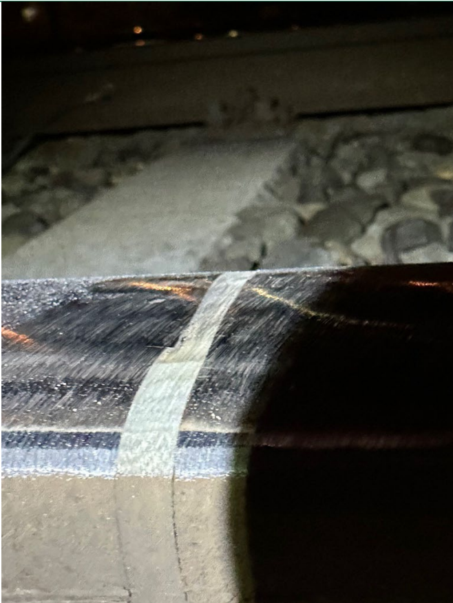
Klein licht holletje voelbaar. Let op de las is wel vlak, foto lijkt ander beeld te geven
