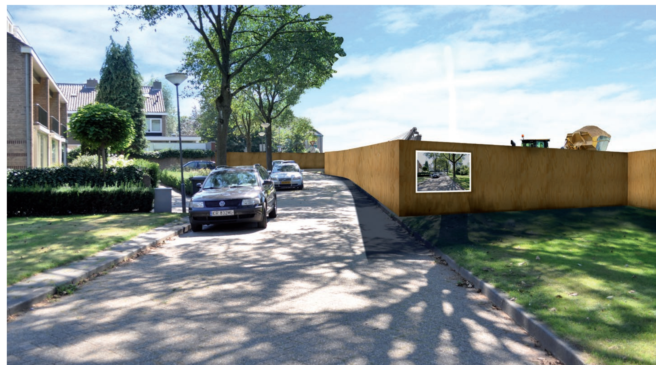
Isabellastraat (kijkend richting het zuiden)
