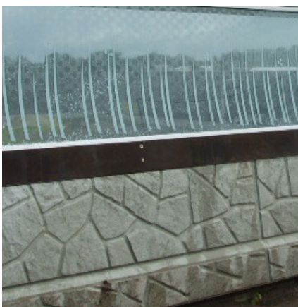
Voorbeelden van een fraai afgewerkte betonnen rand van de bak.
