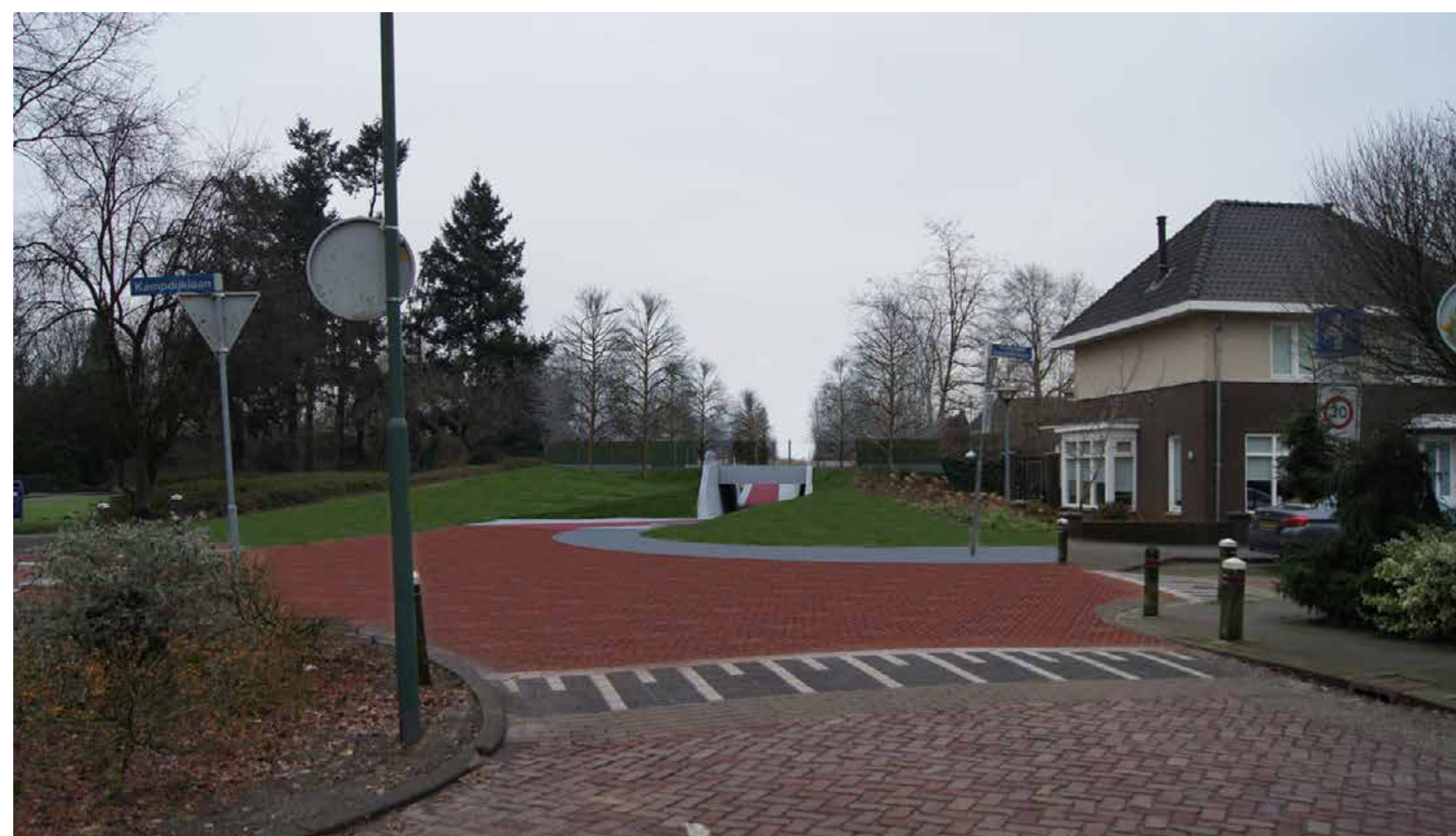
Onderdoorgang Loonsebaan, gezien vanaf de westzijde
