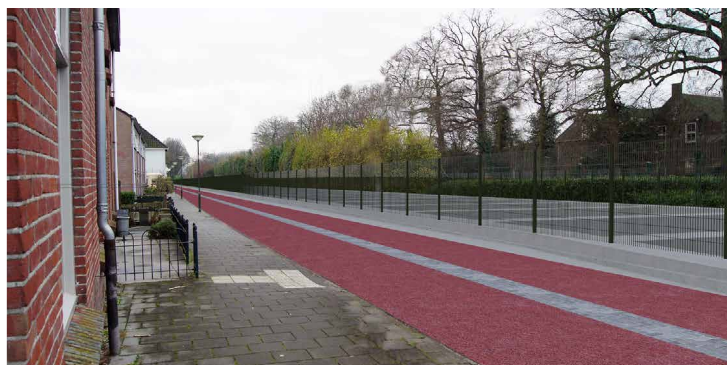
Zicht op verdiepte ligging – Spoorlaan ter hoogte nr 1, kijkend richting het zuiden
