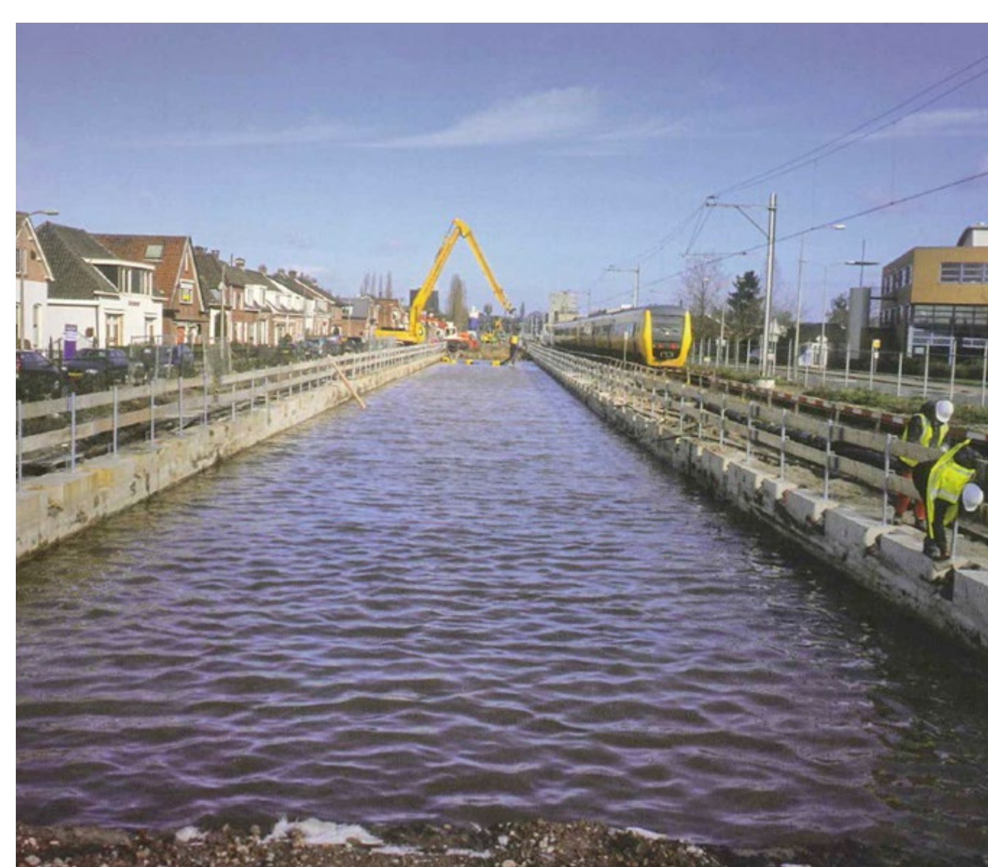
Stap 3 dekken (overgangen) aanbrengen en vloer storten (onderwaterbeton)
