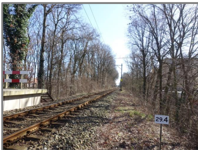
Fig. 4: Sectie A: Links t.h.v. Station Lammenschans. De beplanting van hoog opgaande bomen dicht langs het spoor leidt tot risico's voor het treinverkeer en voor de infrastructuur van ProRail. Uitbrekende takken en toppen en omvallende bomen kunnen op het spoor terecht komen. Het beheer is erop gericht de bomen te behouden, maar daarbij wel het risico voor het spoor te verminderen door in de richting van het spoor groeiende takken en toppen in te nemen. Rechts: het terrein van ProRail loopt ca. 3 meter door voorbij het hekwerk en sluit aan bij de brede gemeentelijke groenstrook aan de Melchior Treublaan.
