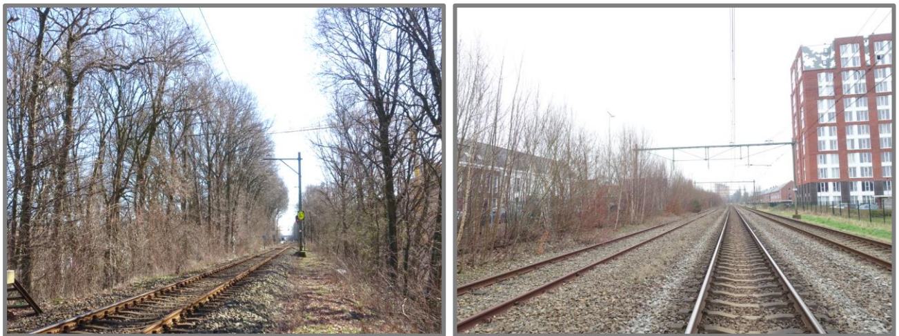
Fig. 2: De vegetatie in de 8 secties verschilt sterk van elkaar. Links: hoog opgaande bomen vlak langs het spoor (sectie A) vormen een hoog potentieel risico voor het treinverkeer en de infrastructuur van het spoor. Daarentegen hebben de bomen een belangrijke schermfunctie voor de bewoners van de Melchior Treublaan en een belangrijke ecologische functie. Rechts: natuurlijke opslag van berk en wilg op twee ongebruikte sporen t.h.v. de Blauwe Tramstraat (sectie E). Veel van deze meerstammige jonge bomen zijn nog niet kapvergunningplichtig. Indien zij door kunnen groeien kunnen zij kapvergunningplichtig worden, uiteindelijk ruim 20 meter hoog worden en een risico gaan vormen voor het treinverkeer. De begroeiing heeft een belangrijke schermfunctie voor de bewoners van de Blauwe Tramstraat. Door een gericht beheer kan de doorgroei van de boomvormers beteugeld worden, zodat de risico's voor het treinverkeer laag blijven maar de begroeiing wél zijn schermfunctie kan blijven vervullen.
