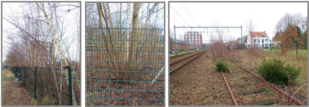
Fig. 9: Sectie E: Bomen en boomvormers die vlak bij of tegen het hekwerk van ProRail groeien zullen binnen 1,0 m van het hek geheel worden weggehaald om het beklimmen van het hekwerk en beschadiging van het hekwerk te voorkomen (foto links). Ook alle snelgroeiende boomsoorten (wilg en populier) zullen 1x per 4 jaar geheel worden afgezet op de stobbe (foto midden). Ook ten zuiden van het Boedapesterhof zal de schermfunctie van de boomvormers behouden blijven en worden verbeterd door het periodiek selectief verwijderen van alleen de dikste stammen (foto rechts).
