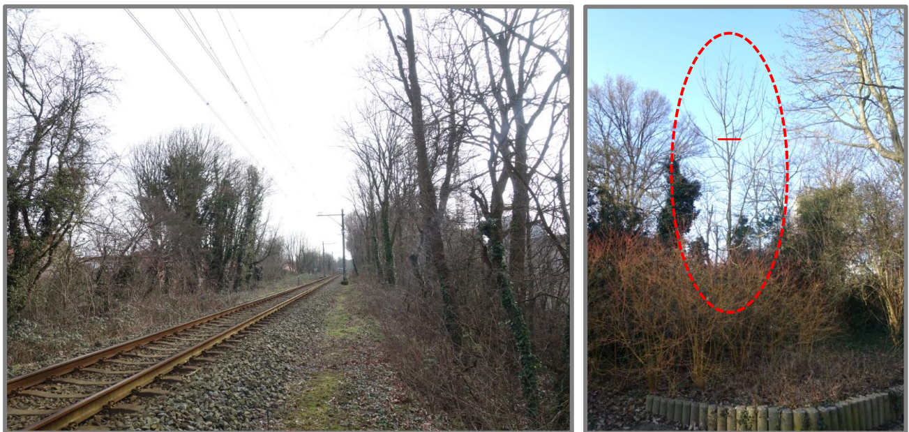
Fig. 5: Sectie B: T.h.v. de Kastanjekade staan eveneens hoog opgaande bomen aan weerszijden van het spoor (links). Ook hier veroorzaakt dit een verhoogd risico op hinder en schade aan het spoor indien bomen of delen daarvan bezwijken en op het spoor terecht komen. Aan de zijde van de Kastanjekade loopt de groenstrook van ProRail voorbij het hekwerk over in een gemeentelijke groenstrook met hoge bomen, boomvormers en struiken (foto rechts). Het beheer van de groenstrook is erop gericht om het doorgroeien van boomvormers te voorkomen (rechts).
