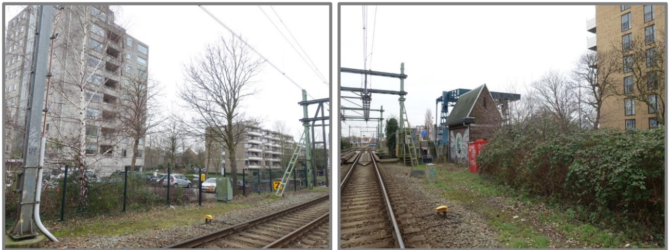
Fig. 13: Sectie G: In sectie G staan alleen aan de rechterzijde van het spoor 2 bomen (foto links). De bomen staan op terrein van ProRail in een smalle groenstrook aan het parkeerterrein Bloemlustplein. Doordat de bomen vlak langs het hekwerk staan, verdrukken zij met hun stamvoet het hekwerk. Daarom worden de bomen gekapt en vervangen voor groenblijvende hoog opgaande heesters in de groenstrook buiten het hekwerk. Aan de linkerzijde van het spoor (foto rechts) stopt het ProRail-terrein vóór het overgroeide hekwerk dat in een smalle groenstrook van Gemeente Leiden staat.
