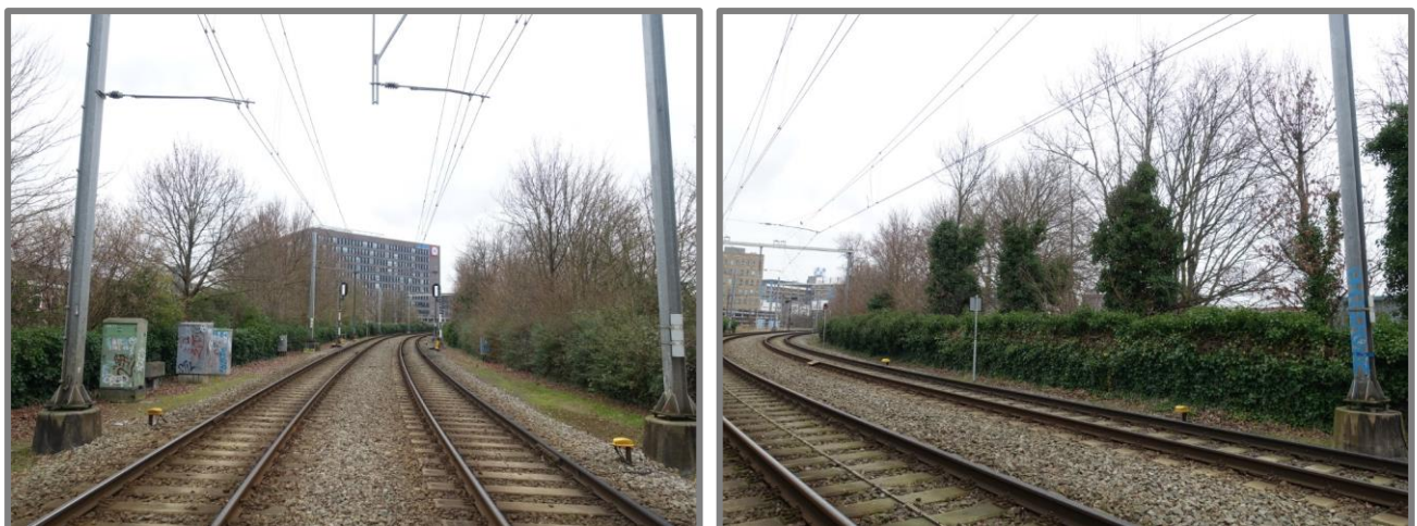
Fig. 14: Sectie H: In sectie H staan er aan weerszijden van het spoor opgaande beplantingen van bomen en heesters. Deze beplantingen hebben een belangrijke schermfunctie en een hoge ecologische waarde. Door verdere groei in hoogte en breedte vormen de bomen een toenemend risico voor het spoor en treinverkeer. Door de boomkronen nabij het spoor in hoogte en in breedte periodiek in te nemen, blijven de bomen compact en kunnen zij langdurig behouden blijven zonder dat zij een risico vormen voor het spoor.
