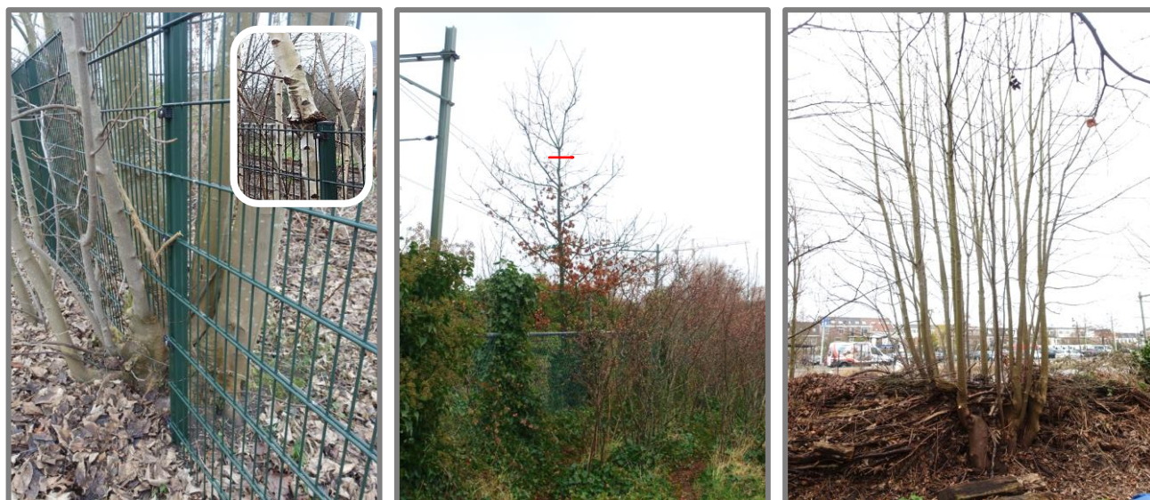
Fig. 14: Bomen en boomvormers die met de stamvoet of stam tegen infrastructuur van ProRail groeien, zullen worden verwijderd (foto links). Veel jonge bomen van de 1 e grootte worden uiteindelijk ruim 20 meter hoog en gaan daardoor een risico vormen voor het spoor (foto midden). Door tijdig de doorgaande top uit de jonge bomen te verwijderen en ook de richting het spoor groeiende takken in te korten, kunnen de bomen in een meer compacte vorm langdurig behouden blijven. T.h.v. de woonboten aan het Spoorweghavenpad (sectie E) worden boomvormers reeds als hakhout beheerd (foto rechts). Hakhoutbeheer en het knotten van knobomen dient na de bladval uitgevoerd te worden en ruim vóór het uitlopen van de bladknoppen. De in dit beheerplan gehanteerde termijn is 1x per 4 jaar.
