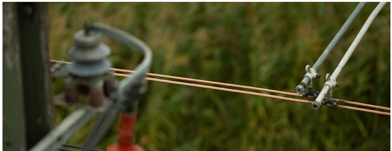
3 De eerste 100% gerecyclede rijdraad ter wereld (Foto: Shane van Hattum)
