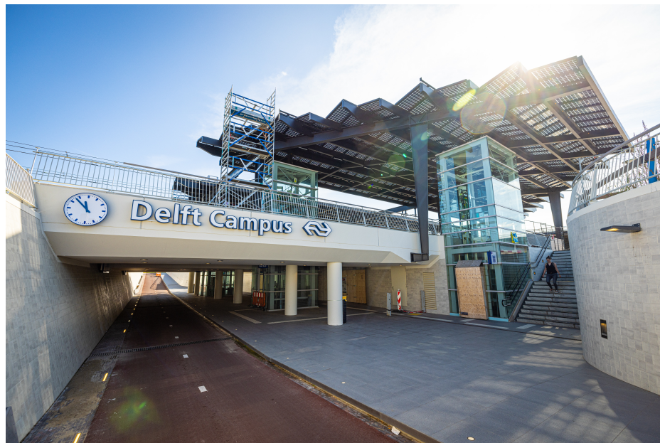
Figuur 2: zonnepanelen Delft Campus.
