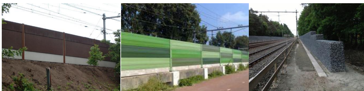
Figuur 7: Verschillende typen geluidsschermen (Bituned, Hollandscherm en Strukton).
