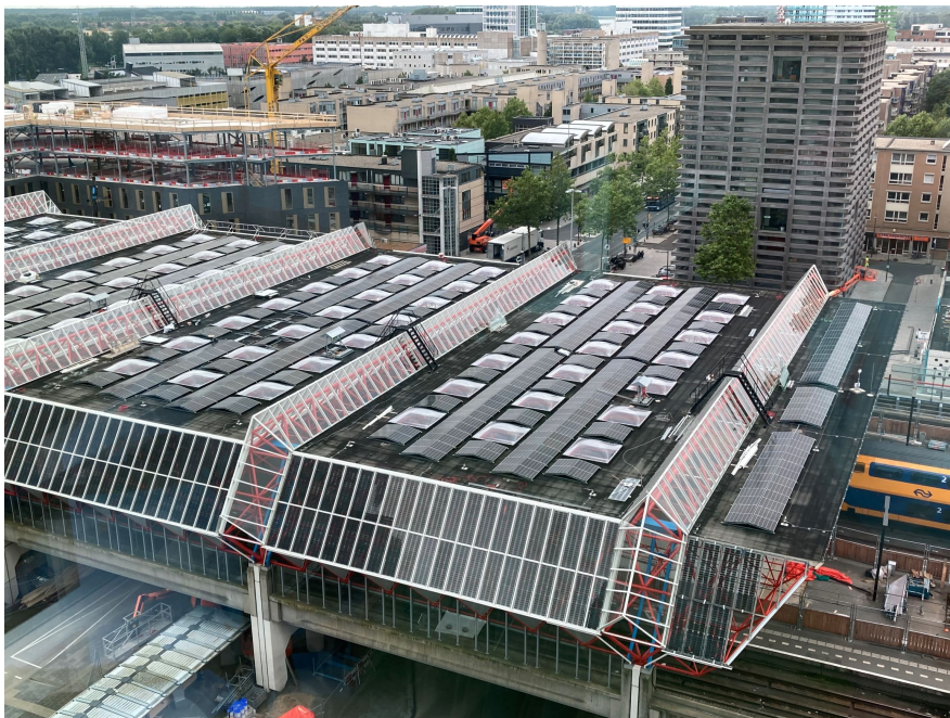
5.1: foto zonnepanelen station Almere Centrum.
