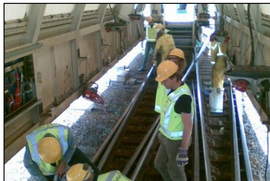
Afbeelding 8: interieur mobiele werkplaats.
