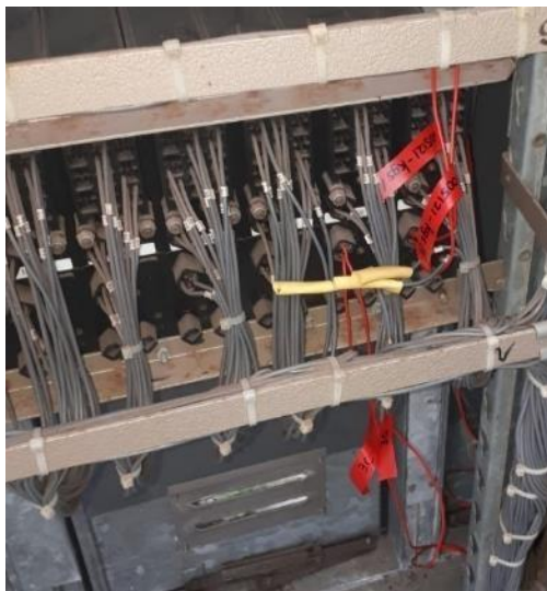
Foto 3. Relais in relaiskast RK717B met stropen van de naderingsrelais van de brug (stropen).
