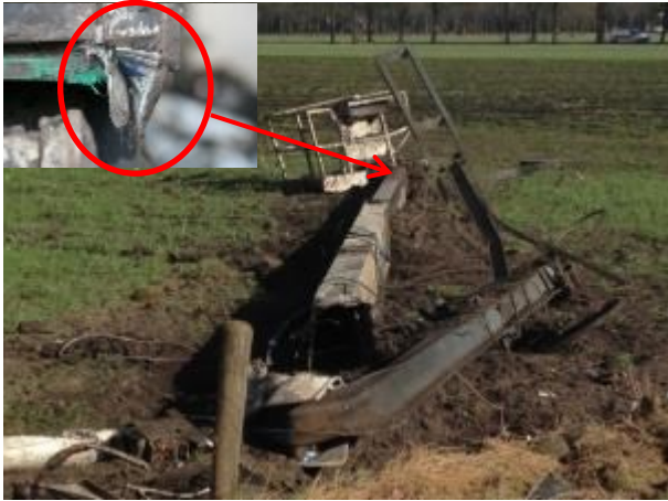
Figuur b10. Afgebroken deel giek met werkbak.
