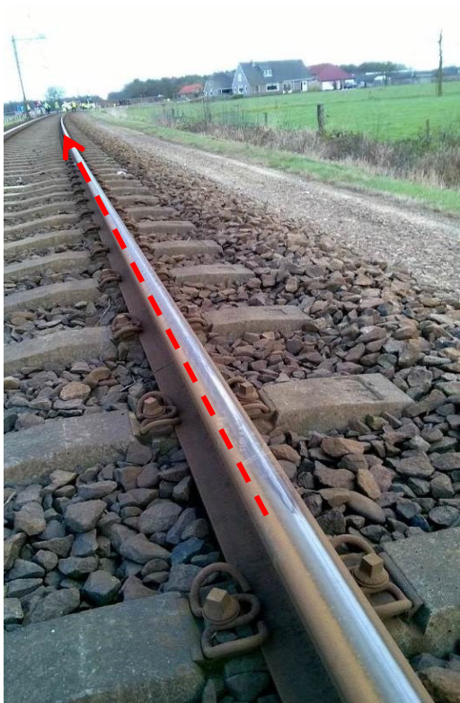
Figuur 5. Begin van het sleepspoor van de magneetrem.
