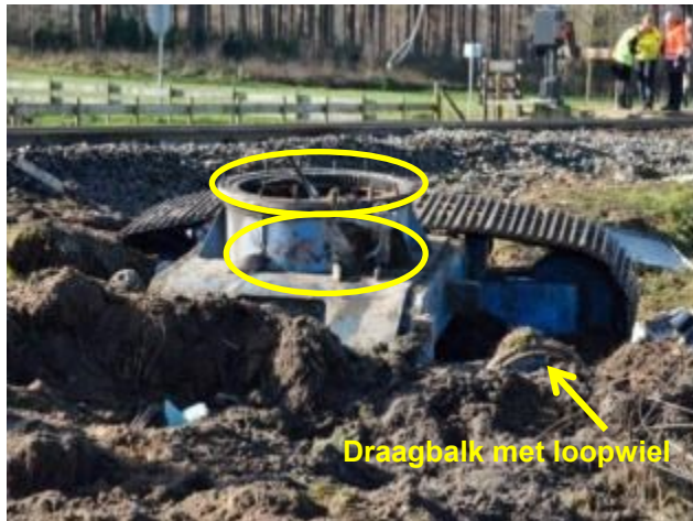
Figuur b7. Het rupsonderstel van de hoogwerker.
