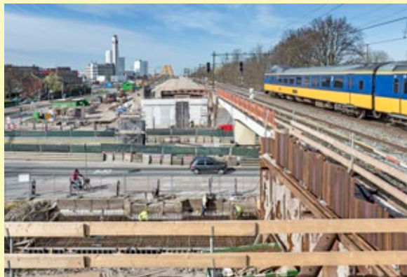
Bij de Thomas à Kempisweg is het nieuwe viaduct in aanbouw deze zomer af.
