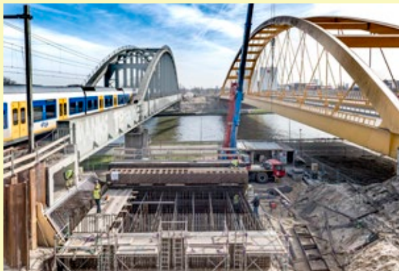
Sinds november 2016 verrijzen aan beide zijden van het Amsterdam-Rijnkanaal de ondersteuning voor de nieuwe spoorbrug.
